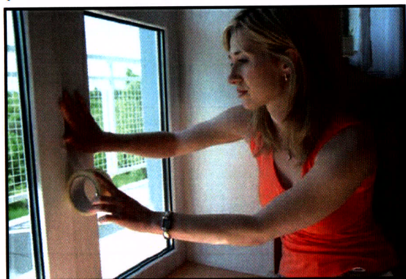
Obr. 2: Utěsnění oken lepicí páskou.
